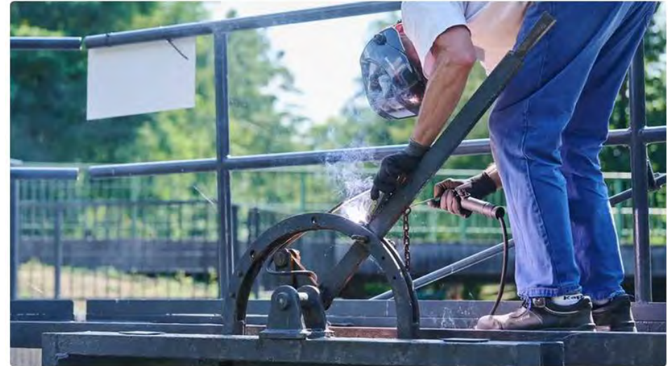
Ein Mitarbeiter des Wasser- und Bodenverbandes Nördlicher Spreewald schweißt den Hebel der Schleuse in Groß Wasserburg zu. 2022 kam es durch Niedrigwasser zu dieser Maßnahme.
